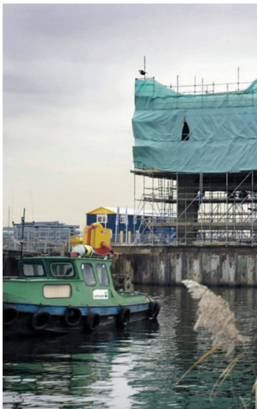
Kraanspoor in aanbouw op het NDSM-terrein in Amsterdam Noord.
