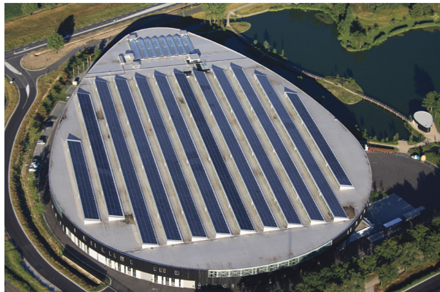
Toepassing kennis AliusEnergy in Slimbouwen gebouw Venco Campus met breeam outstanding certificaat.
