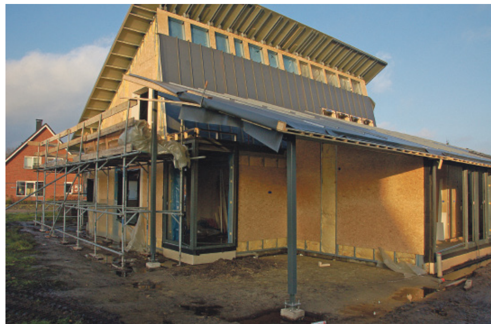
Aanzicht HoTT in aanbouw.
