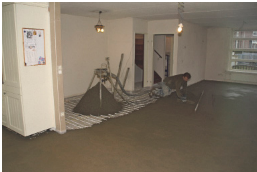
Al lang wordt het traditioneel aanbrengen van zandcementvloeren (het zogenoemde smeren) gezien als één van de zwaarste activiteiten op de bouwplaats.
